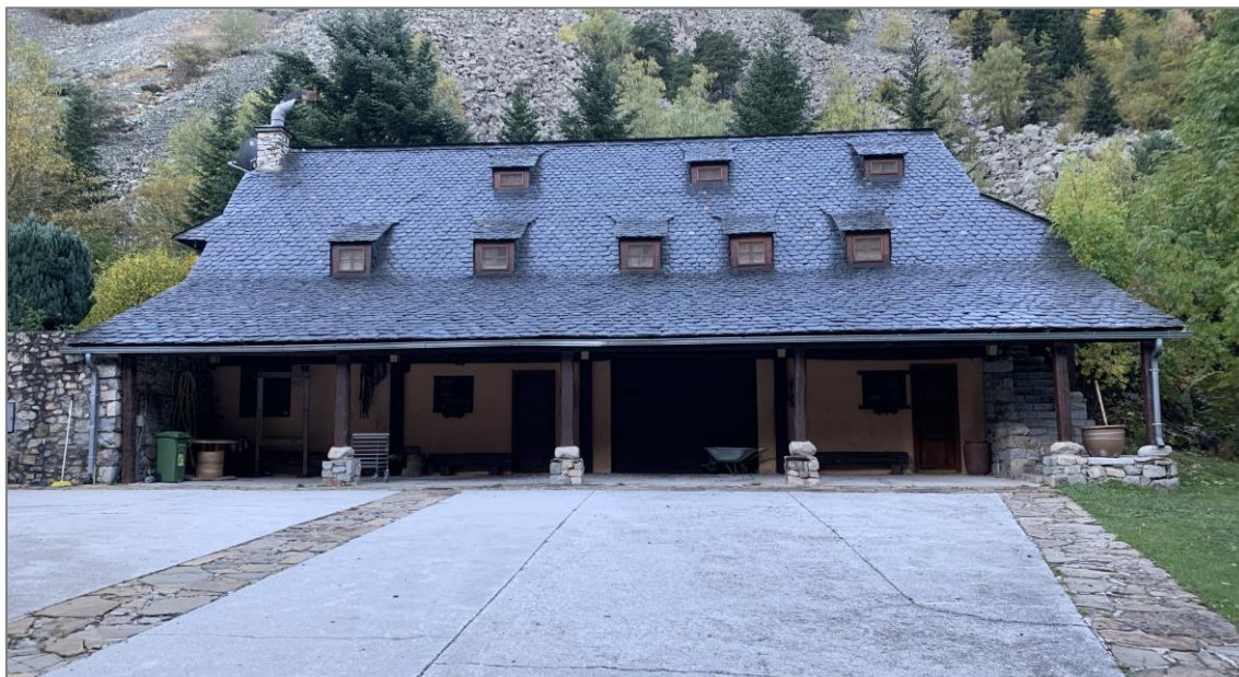
Fotografia 7. Edifici 2 de l'àmbit del PAE.
