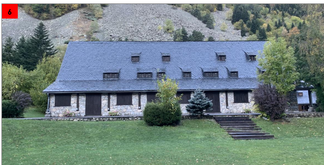
Fotografia 16. Vista est de l'edifici 1.
