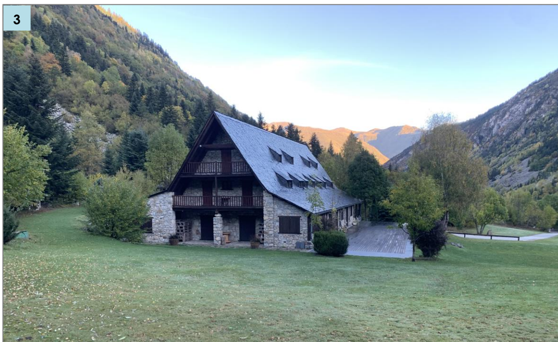
Fotografia 13. Vista del costat nord de l'edificació existent 1.
