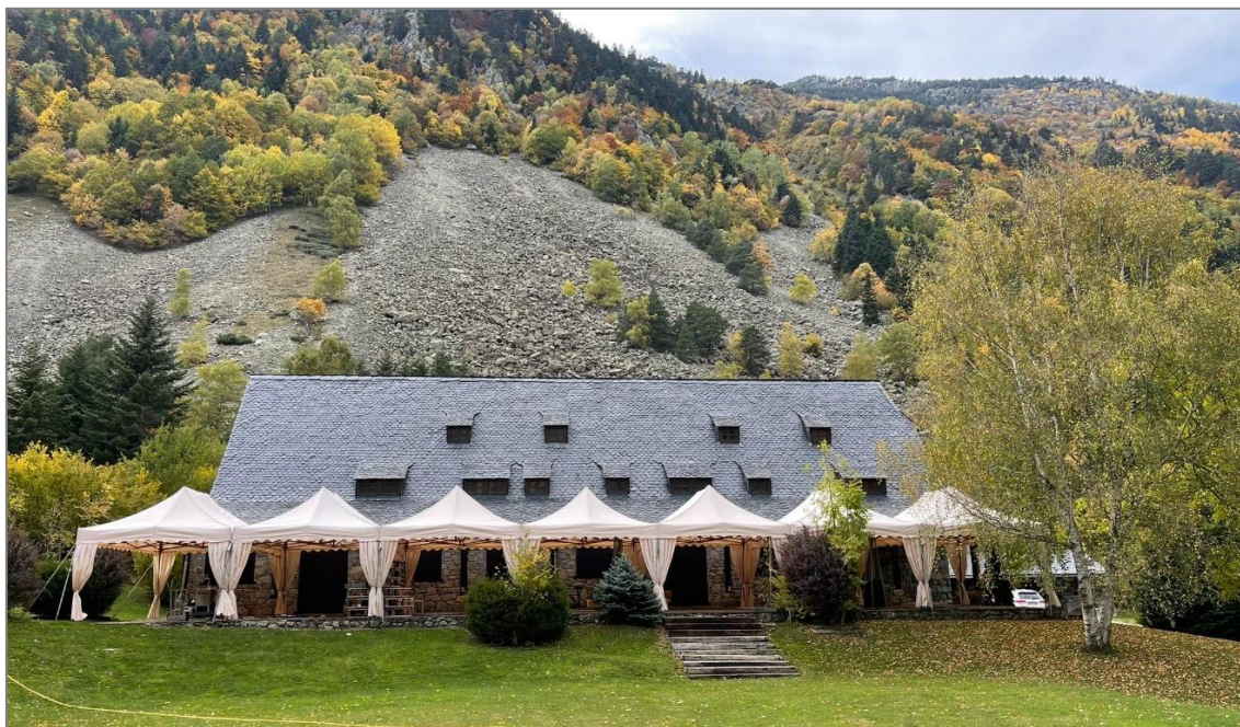
Fotografia 6. Edifici 1 de l'àmbit del PAE del TM de Naut Aran.
