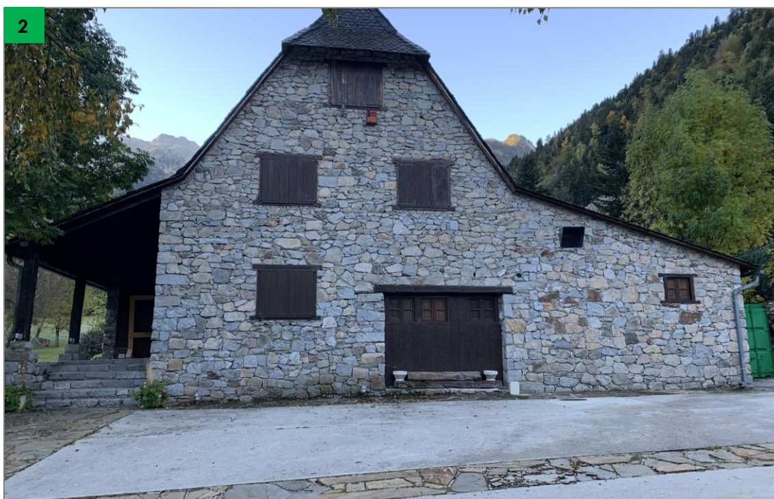
Fotografia 12. Vista del costat sud de l'edificació existent 1.
