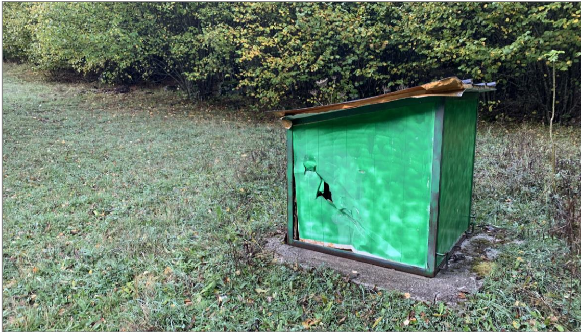
Fotografia 21. Pou/Dipòsit d'aigua soterrat.
