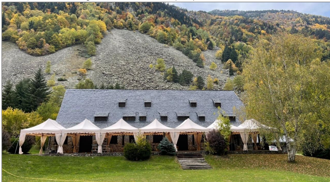
Fotografia 13. Vista O de l'edifici principal de l'àmbit del PAE.
