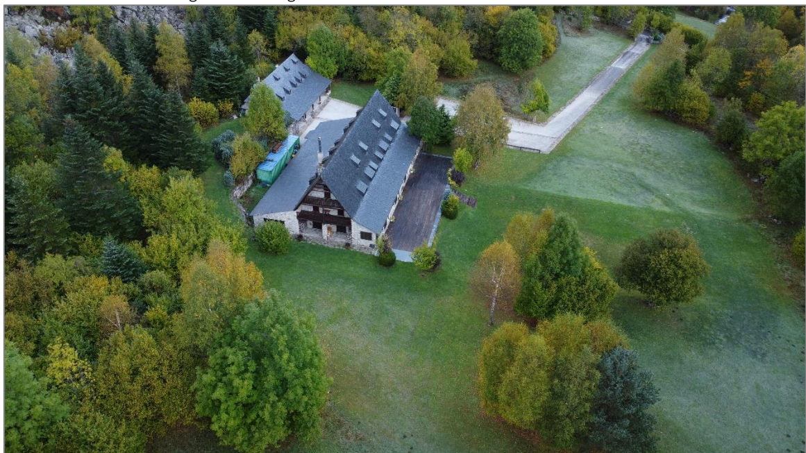
Fotografia 3. Imatge actual de l'àmbit del PAE des de la banda sud.
