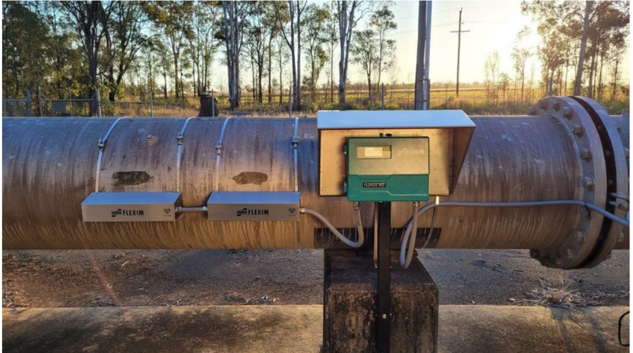
Exemple d'instal·lació de comptador ultrasònic a l'exterior d'una canonada
