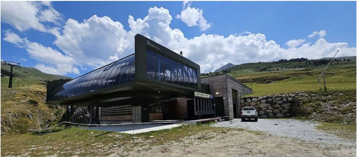
Instal·lació Dossau, similar al nou telecadira del Mirador
