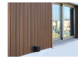
Revestiment de fusta
