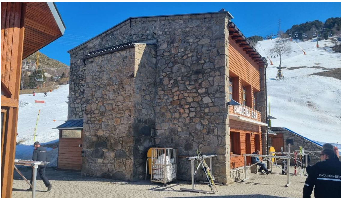
Edifici del Bar que es demolirà.
