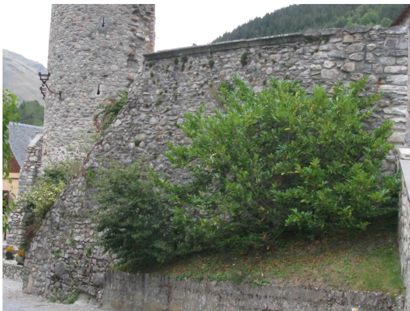
Vedença dera grada abantes deth sòn esbaussament en sòn sector oèst
