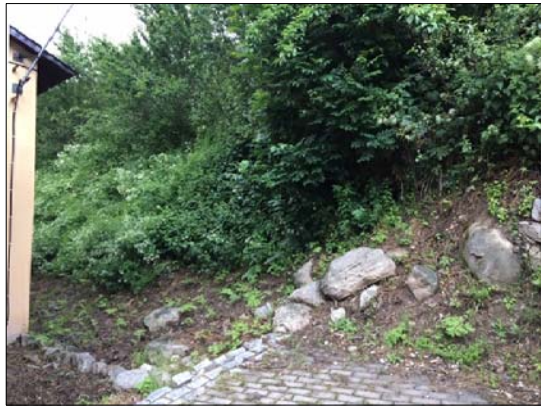
ZONA CONEXIÓ CANALIZACIÓ
