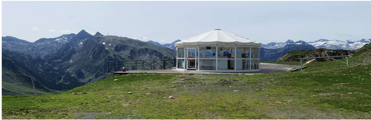
Estat actual de la cafeteria del Parrèc Blanhíblar.
