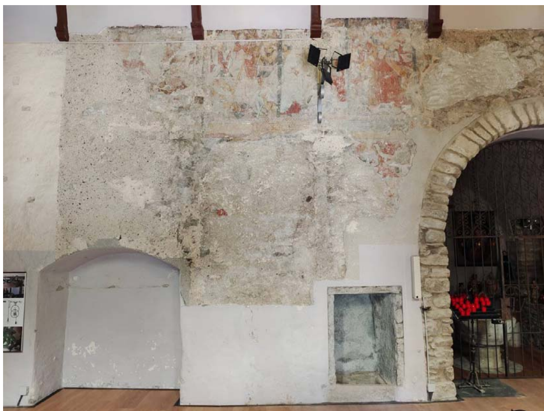
La zona esquerra de la paret nord després de la fase 1
