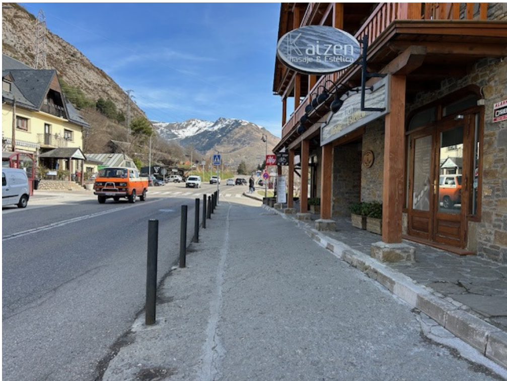
Foto6. Panorámica actual ámbito de la obra. Fase I
