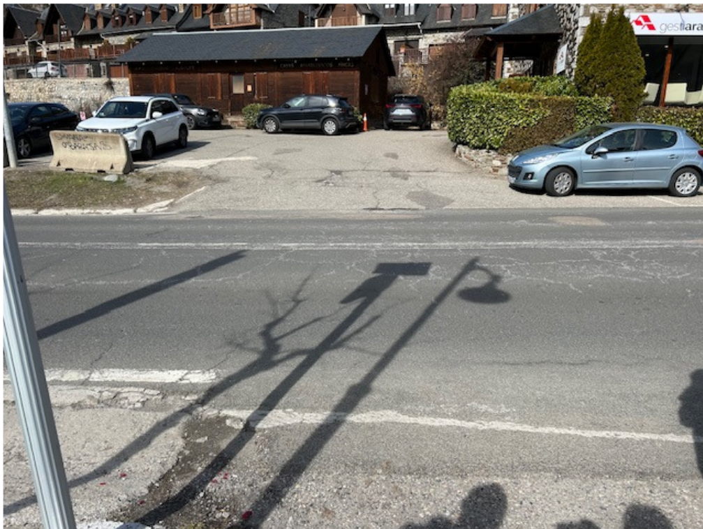
Foto2. Panorámica actual ámbito de la obra.
