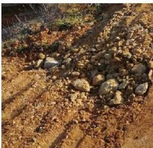
Imagen. Tapado de zanja con mismo material extraído
