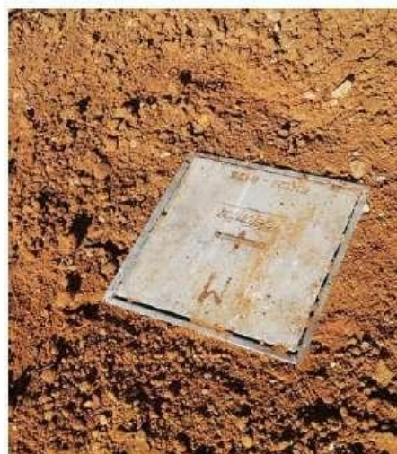
Imagen. Arqueta M construida a ras de suelo
