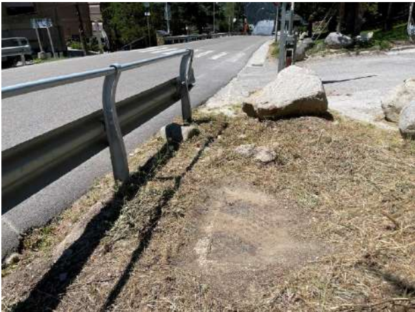
Fig.1.1.1.1.a. Inici de l'obra, pericó existent 25025PE0024.
