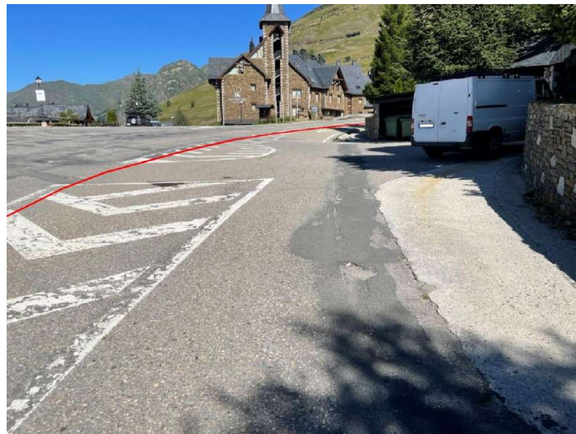
Fig 1.2.4.1.14. Tram d'obra civil entre 25025PE2008 i 25025PE2009.
