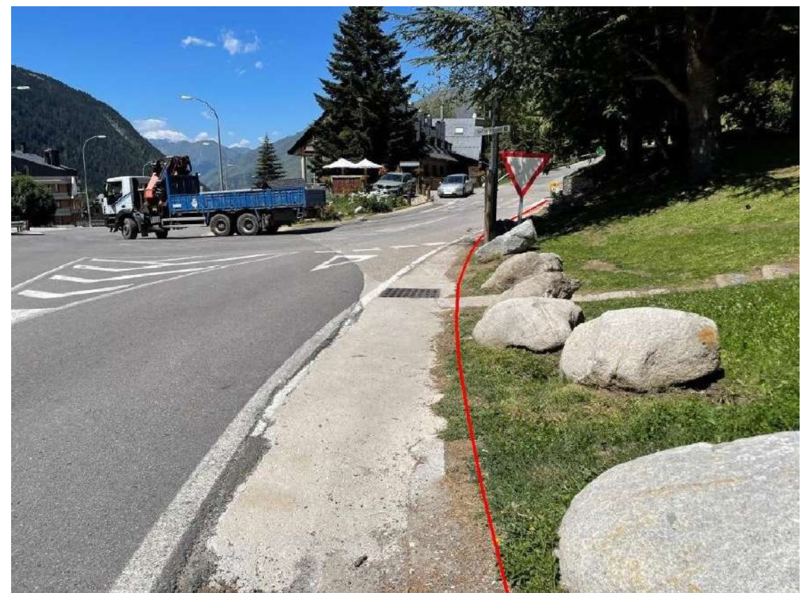
Fig 1.2.4.1.4. Tram d'obra civil entre 25025PE0024 i 25025PE2000.
