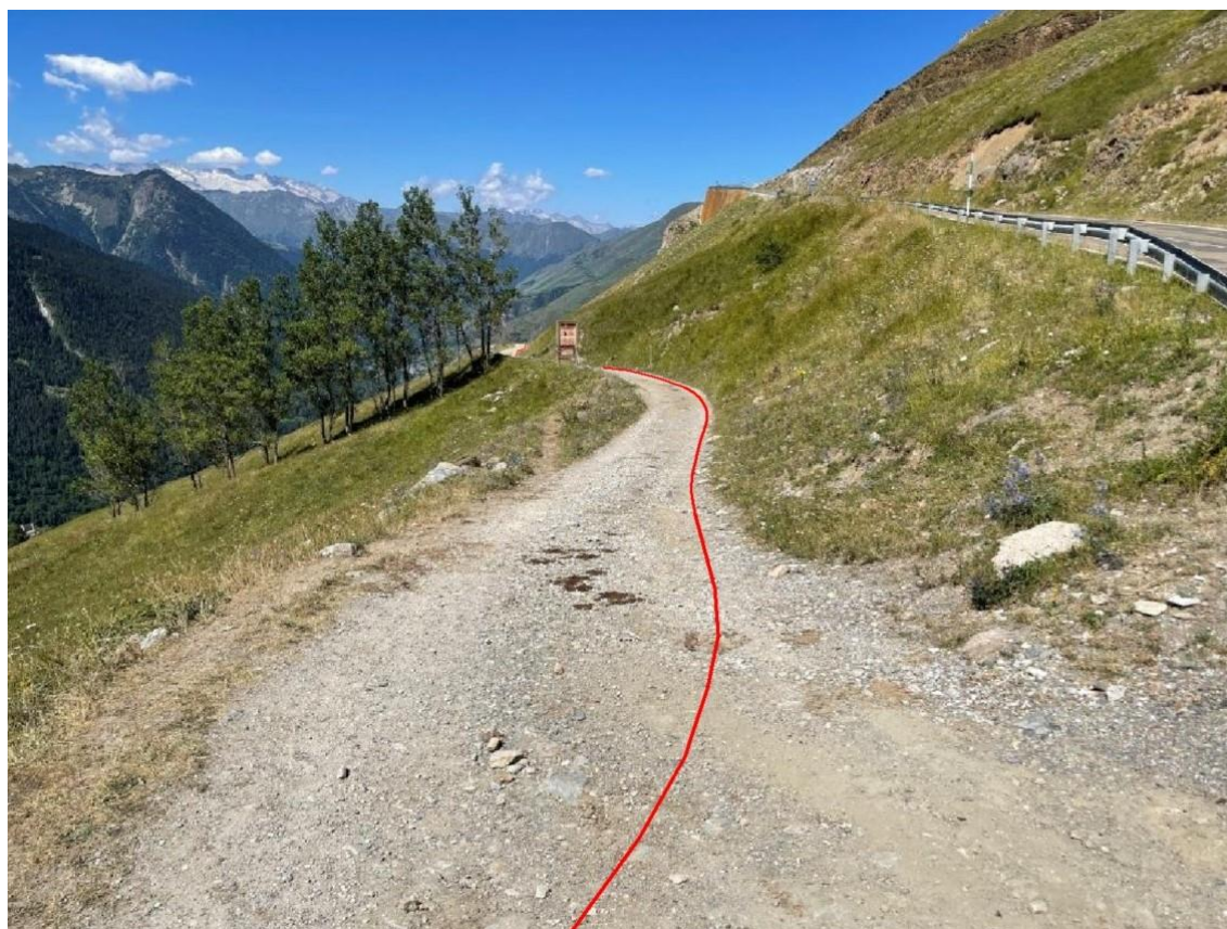
Tram obra civil entre 25025PE2017 i 25025PE2018.
