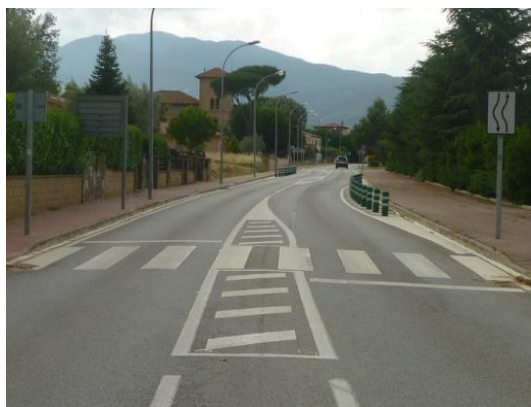
Imatge 43. Exemples de mesures de fàcil aplicació per l'estretament d'amples de calçada
