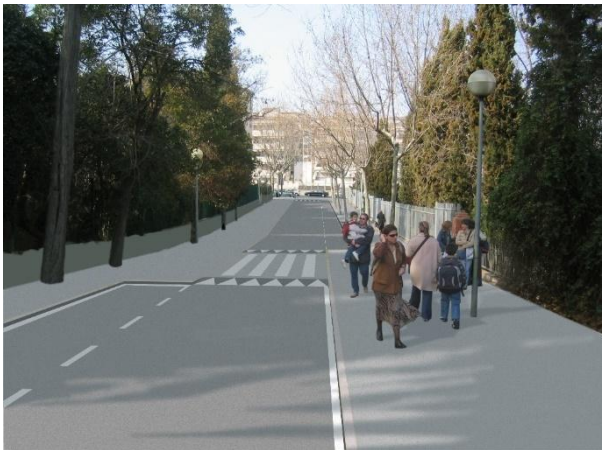
Imatge 58. Carrer amb sentit únic i aparcament alternatiu, que permet l'ampliació de voreres
