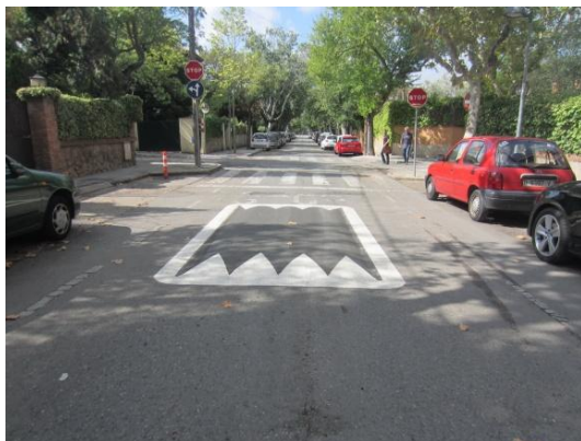
Imatge 44. Exemples de coixins berlinesos d'asfalt. Municipi de Sant Cugat del Vallès
