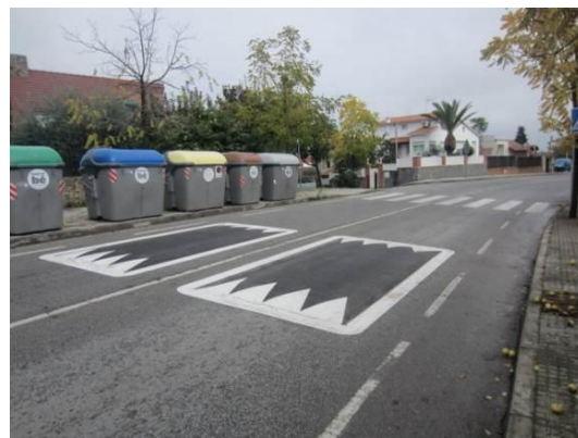
Imatge 44. Exemples de coixins berlinesos d'asfalt. Municipi de Sant Cugat del Vallès
