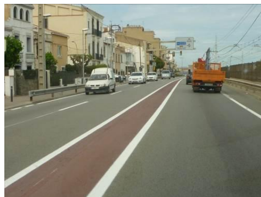
Imatge 43. Exemples de mesures de fàcil aplicació per l'estretament d'amples de calçada
